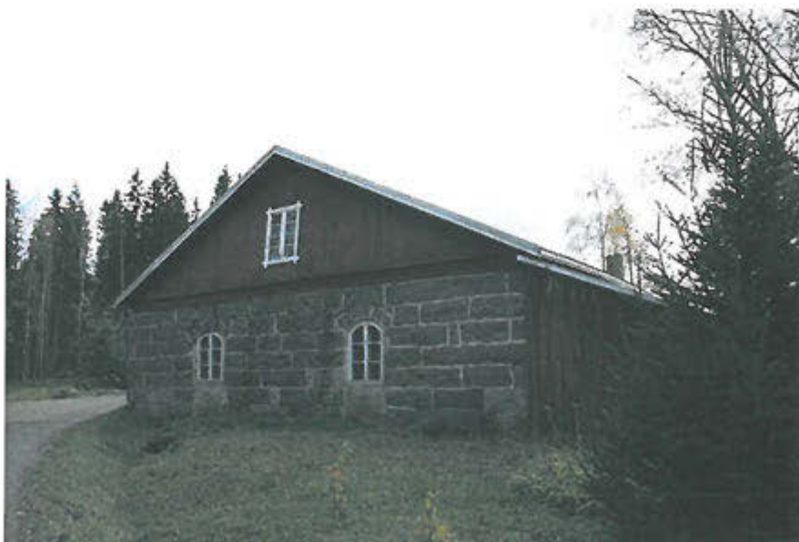
Kuva 12. Rajalan pihapiiriin kuuluu harmaakivinavetta 1900-luvun alusta. (Kuva: Heidi Ahlgren)
