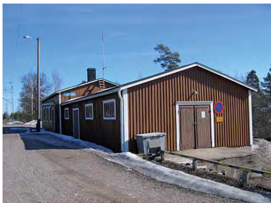
Kuva 2-41 Uudenkylän asemarakennus radan puolelta
