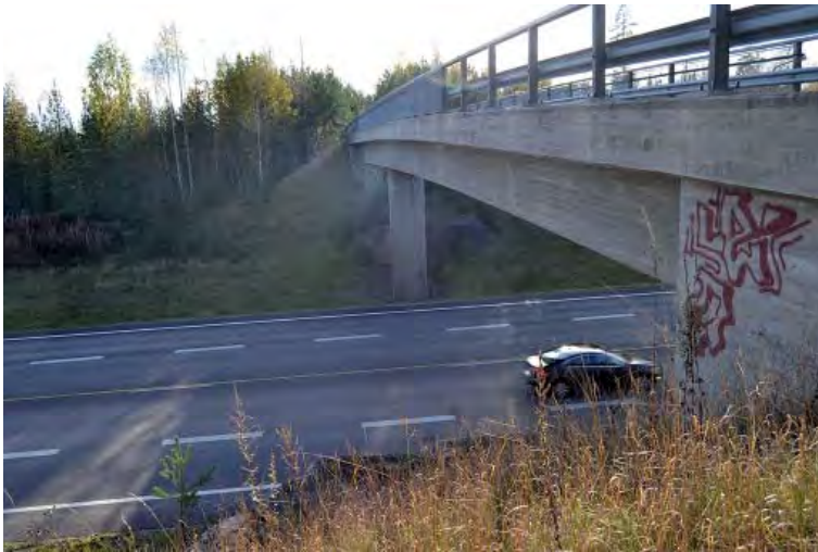
Kuva 4-6 Valtatien 12 ylittävä silta
