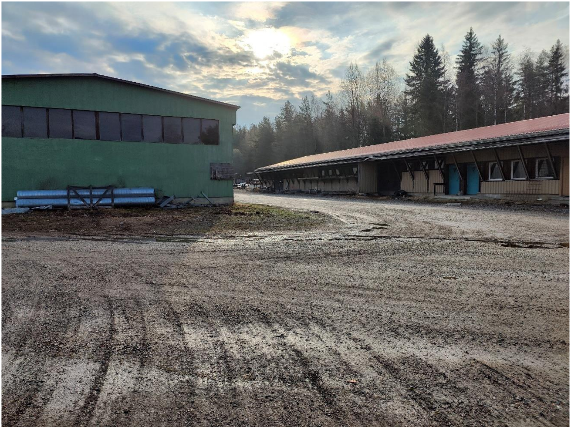
Kuva 15-2. Hankealueen etelälaidalle sijoittuva avoin peltihalli (vas.) sekä vanha kaupparakennus (oik). Rakennukset tullaan purkamaan P2X-laitoksen rakentamista varten. Huhtikuu 2023.
